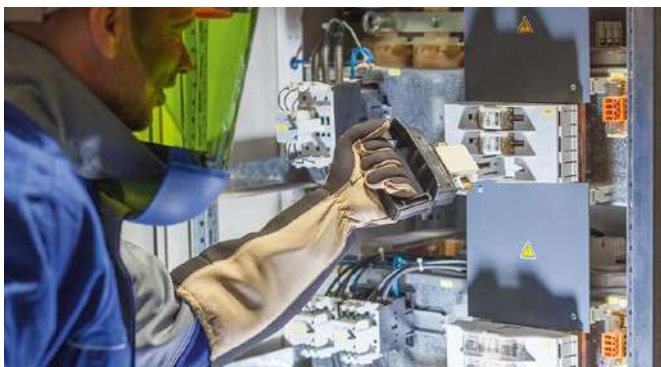
Betätigung eines NH-Aufsteckgriffes mit dem Schutzhandschuh.
